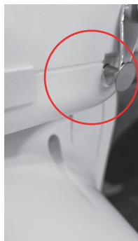
悪い例(図6-1) シャフトが半分ぐら いしかでていない
